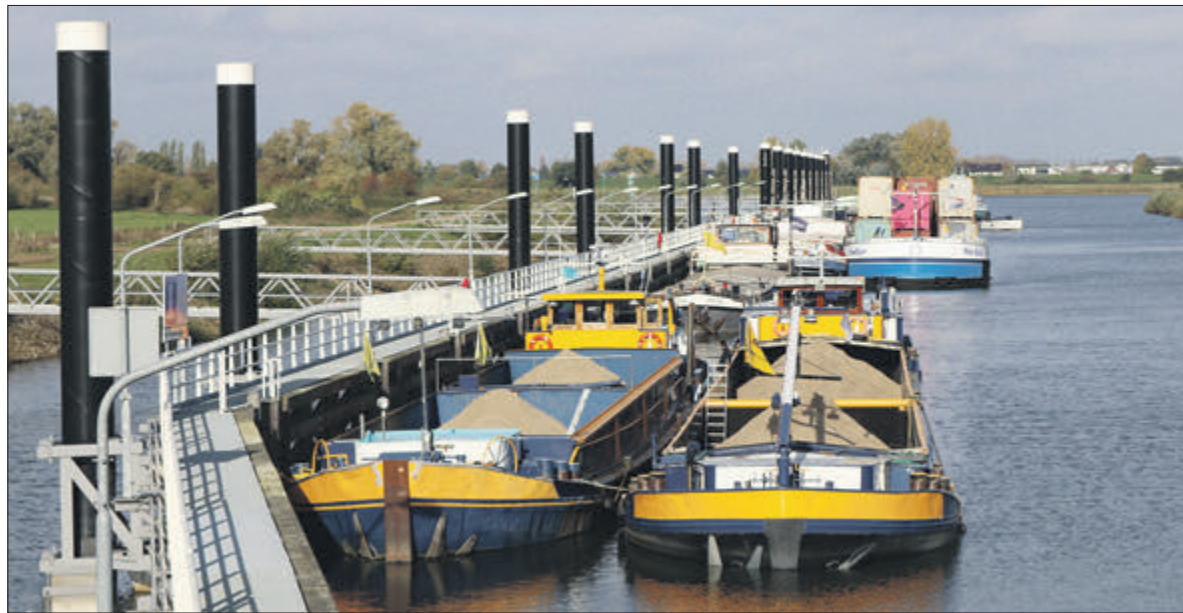
Wachtende schepen voor de defecte sluis van Empel. (foto's Noud van der Zee)
